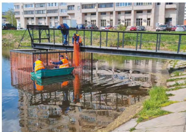
Монтаж дополнительной сетки на шахте водосброса, ГТС «Плотина с водосбросным сооружением на р. Ивановка у ул. Чекистов»
