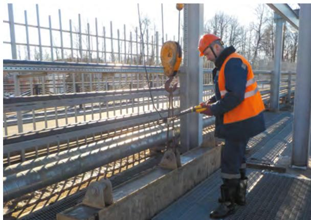
Проверка работы электрических механизмов подъема затворов на ГТС «Плотина №2» в Колпино
